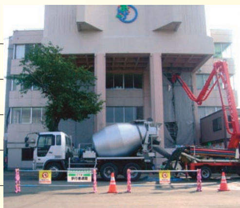
おいらせ町/役場分庁舎耐震補強改修工事
