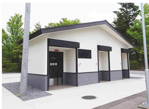
平川市：猿賀公園北側トイレ改築事業
